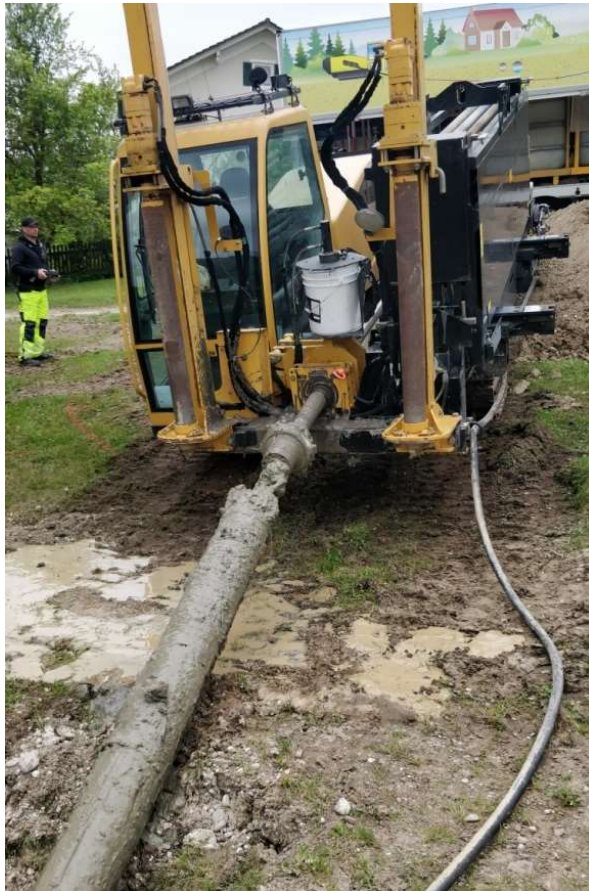
Grabenlose Verlegung im günstigen Spülbohrverfahren
