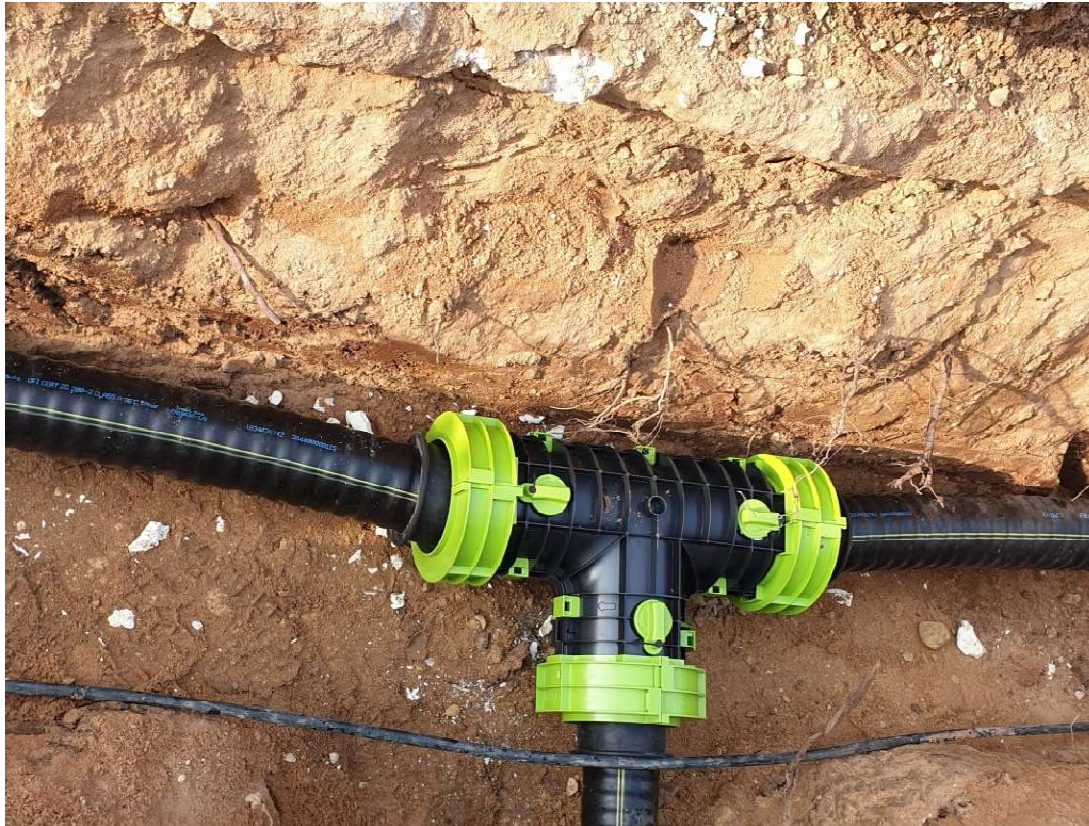
T-Stück im offenen Graben
