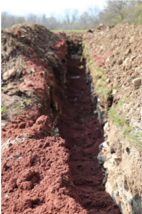
Schließen des Rohrgrabens
