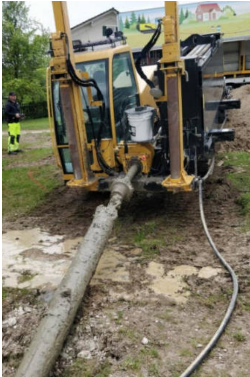
Grabenlose Verlegung im günstigen Spülbohrverfahren
