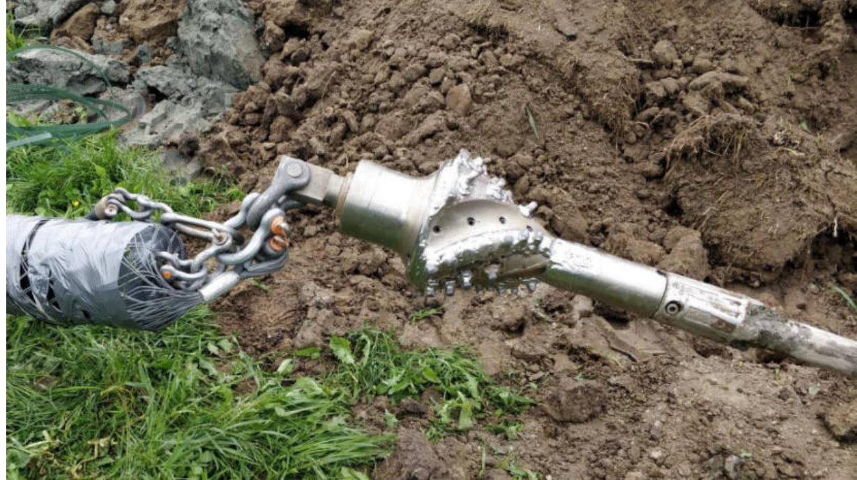
Grabenlose Verlegung im günstigen Spülbohrverfahren
